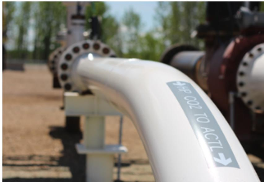
26) In der dichten Phase kann CO<sub>2</sub> bei hohen Drücken ähnlich wie eine Flüssigkeit besonders effizient in Leitungen transportiert werden.
