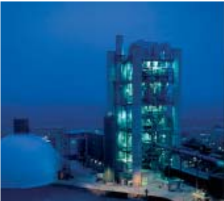
Abb. 4: Ansicht des neuen Drehofens 11 im Werk Lägerdorf
