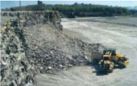
Abb. 4: Steinbruchbetrieb mit Radlader und SKW im gesprengten Haufwerk bei Wandhöhen bis 16 m
