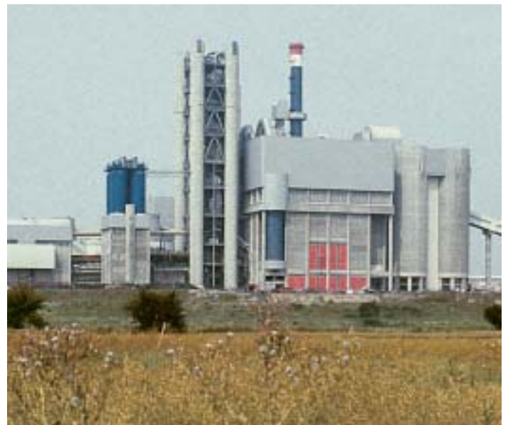
Abb. 4: Moderne Ofenlinie mit Wärmetauscher in Bernburg
