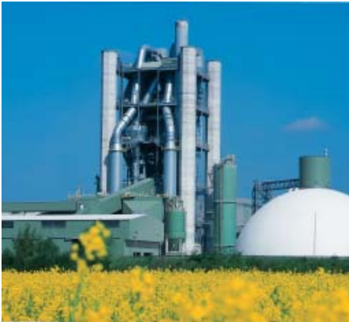
Abb. 6: Teilansicht Werk Lägerdorf
