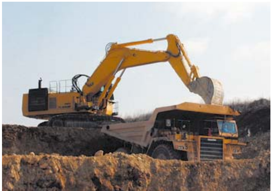
Abb. 6: Direktabbau aus der Steinbruchwand durch einen Hydraulikbagger mit 7,5 m 3 -Tieflöffel auf 85 t-SKW im Jahr 2002
