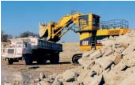
Abb. 5: Hochlöffel-Hydraulikbagger im Reißbetrieb bei Wandhöhen bis 10 m für zweisohligen Abbau
