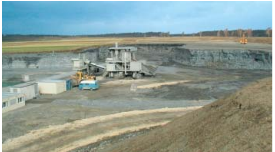
Abb. 5: Ölschiefersteinbruch Dormettingen mit Mobilbrecher
