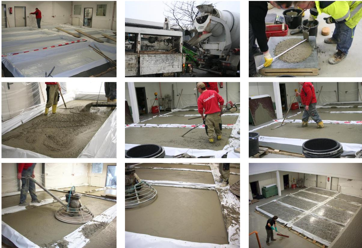
**Bild 13 Betonage horizontaler Flächen am 29.02.2012**
