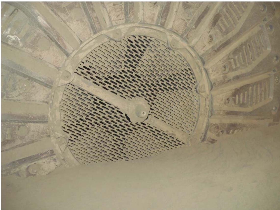
Bild 2-1 Überfüllte Kugelmühle mit verstopfter Austragswand
