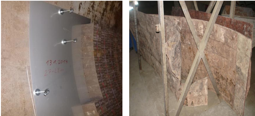
Bild 5 Opferbleche beim Einbau (links) und nach dem Ausbau (rechts)
