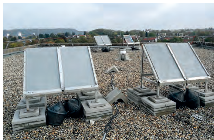
Bild 14: Ansicht der Freilandberegnungsstände
