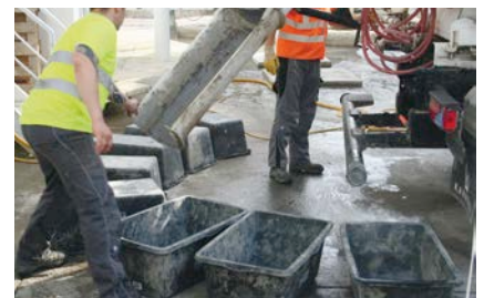
Bild 2: a) Übersicht über Mischanlage, Fahrmischer und Baustellenlabor; b) Ablassen von Frischbeton nach definierten Mischzeiten in den Fahrmischer; c) Ablassen des Frischbetons aus dem Fahrmischer in Mörtelwannen
