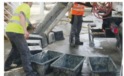
Bild 2: a) Übersicht über Mischanlage, Fahrmischer und Baustellenlabor; b) Ablassen von Frischbeton nach definierten Mischzeiten in den Fahrmischer; c) Ablassen des Frischbetons aus dem Fahrmischer in Mörtelwannen Figure 2: a) General view of mixing plant, truck mixer and site laboratory; b) unloading fresh concrete into the truck mixer after a specified mixing time; c) unloading the fresh concrete from the truck mixer into mortar pans
