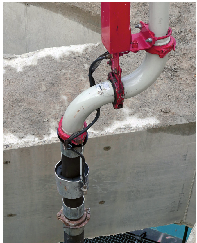
Bild 6: Quetschventil zur kontrollierten Regulierung der Betonsäule
