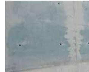
Polysulfide können wie in die-sem Fall unter Luftabschluss bei dicht anliegender Schalung mit gelösten Metallionen zu Metallsulfiden mit grünlich-blaue Färbung reagieren.
