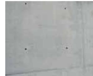
Rund drei Wochen nach dem Ausschalen sind die Metallsulfide durch den Luftsauerstoff zu farblosen Metallverbindungen oxidiert.
