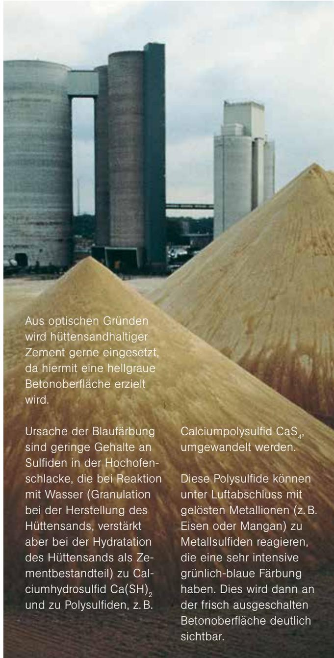
Aus optischen Gründen wird hütten-sandhaltiger Zement gerne eingesetzt, da hiermit eine hellgraue Betonoberfläche erzielt wird.
