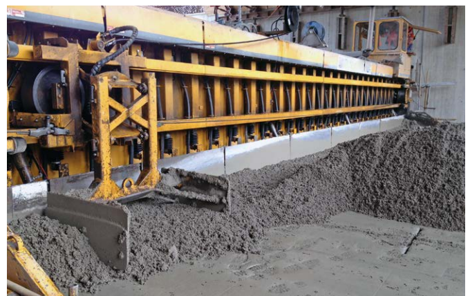
Bild 3: Einbau des Oberbetons, zweischichtige Bauweise
