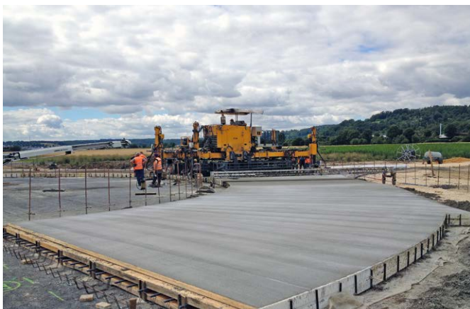
Bild 7: Herstellung einer Beton-Kreisverkehrsfläche mit Fertiger
