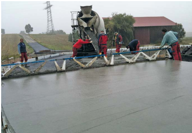
Bild 6: Herstellung einer Beton-Kreisverkehrsfläche im Handeinbau mit Rüttelbohle
