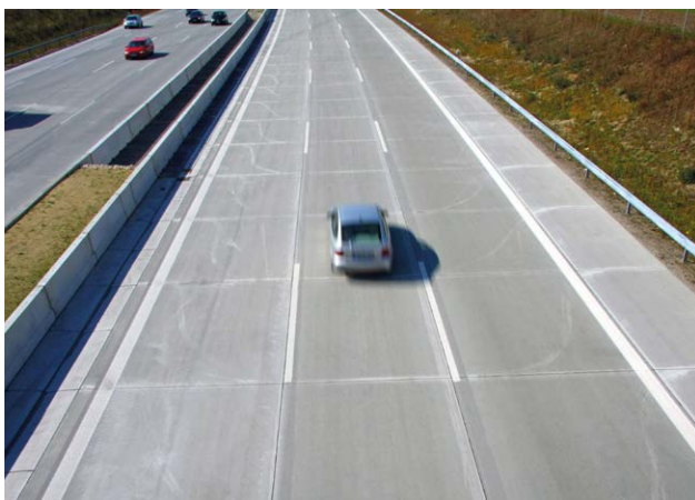
Bild 1: Betonfahrbahndecke im Fernstraßenbau
