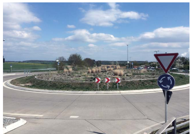
Bild 2: Betonfahrbahndecke im kommunalen Straßenbau
