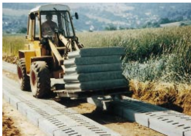
Bild 3: Verlegen von gelochten Spurplatten
