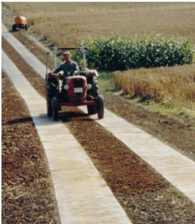
Bild 2: Mit Spurplatten befestigter Spurweg
