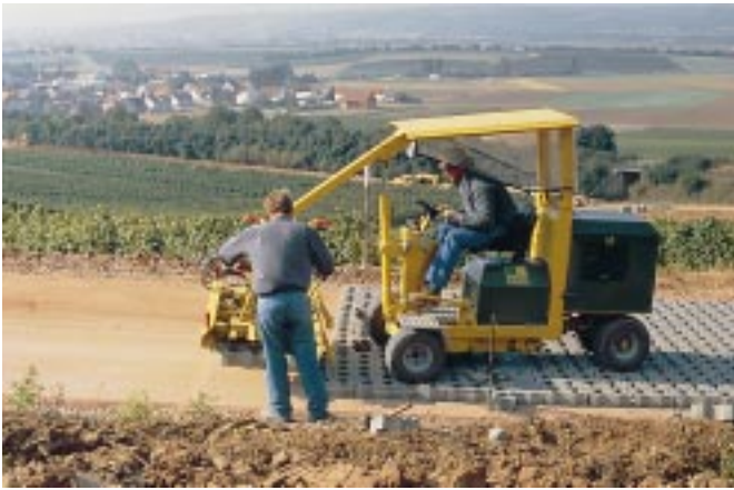
Bild 4: Verlegen von Rasenverbundsteinen mit Verlegemaschine
