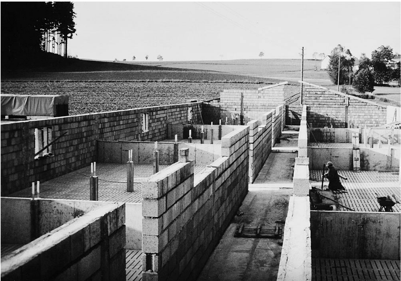
Bild 1: Schweinestall im Bau mit Außenwänden aus Leichtbetonsteinen
