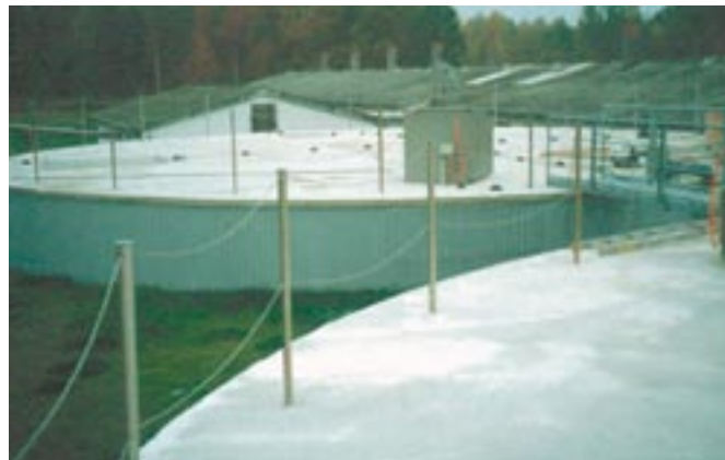
Bild 3: Biogasfermenter mit Betondecke
