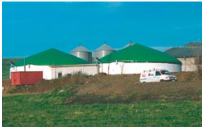
Bild 2: Biogasfermenter mit Foliendach
