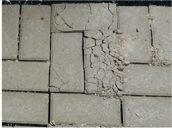
Bild 3.4.16-2 Trennrisse und Ablösen des Vorsatzbetons infolge eines Kernbetonversagens
