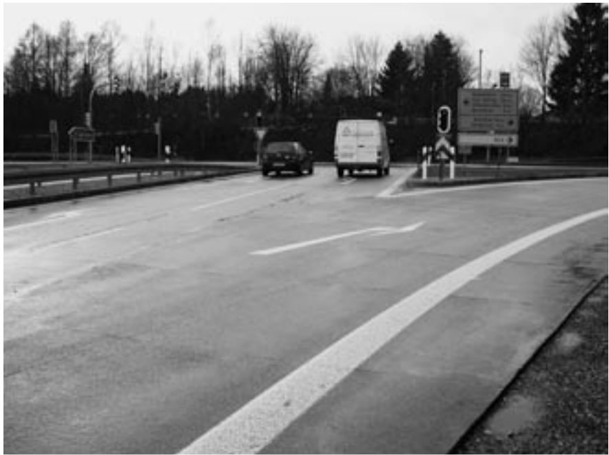
Bild V-54: Whitetopping-Betondecke im Bereich eines Autobahnanschlusses
