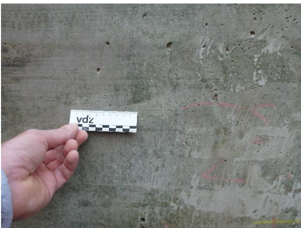
Bild 11 Nach 11 Jahren Betriebsdauer völlig ungeschädigte Betonoberfläche einer Kammerwand von Schleuse 4
