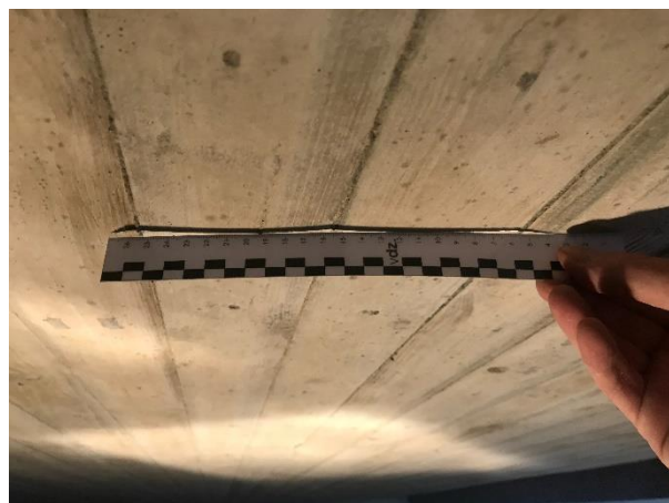
Bild 19 Wellenförmige Untersicht des Überbaus von Brücke 1
