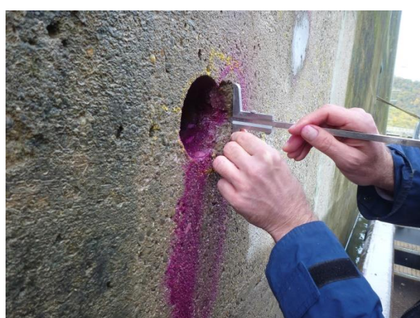
Bild 8 Bestimmung der Karbonatisierungstiefe an einer Bohrkernentnahmestelle der Schleuse 1
