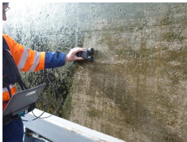
Bild 6 Bestimmung der Betondeckung an der Schleuse 1
