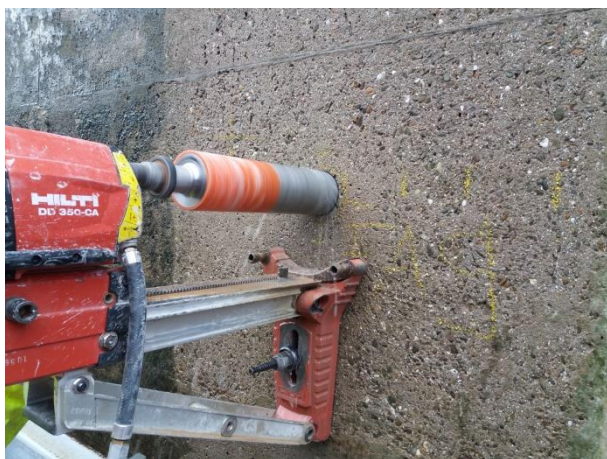
Bild 7 Bohrkernentnahme aus einer Kammerwand der Schleuse 1
