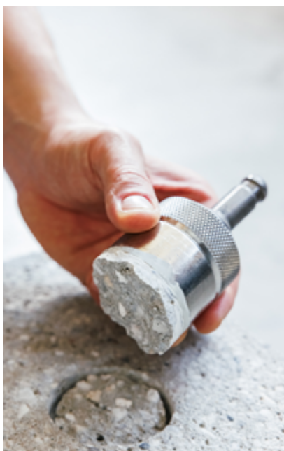
Haftzugprüfung an einer Betonoberfläche
