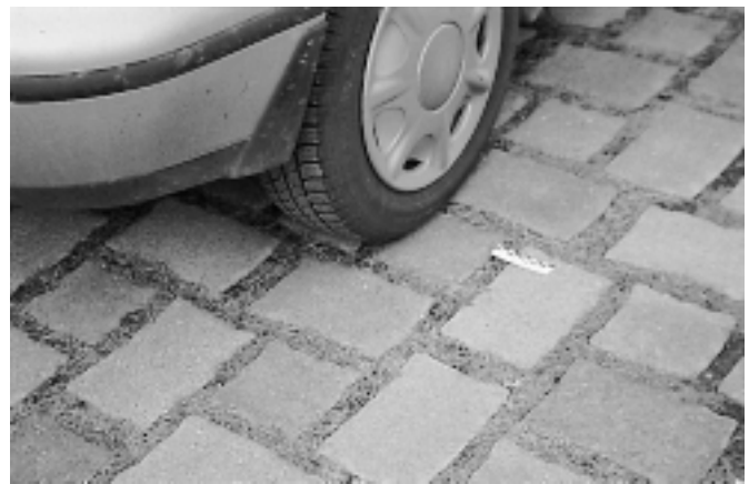
Bild 9: Rasenfugen bei einer Garagenzufahrt
