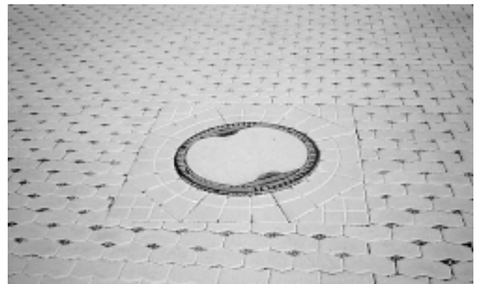
Bild 6: Verbundpflaster mit Sickeröffnungen auf einer Anliegerstraße
