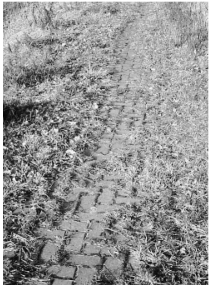
Bild 2: Überwachsen durch „Pflasterritzengesellschaften“ auf wenig beanspruchten Flächen
