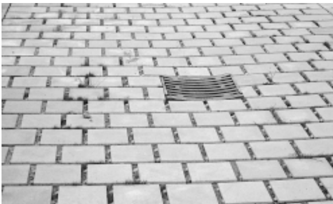
Bild 4: Parkfläche mit 3 cm breiten Pflasterfugen und Notüberlauf
