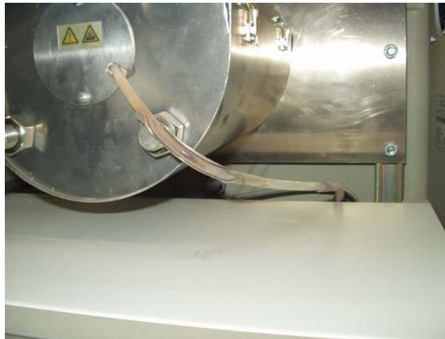
Bild 10: Ablagerungen in der Gasleitung zwischen Katalysator und Kühler
