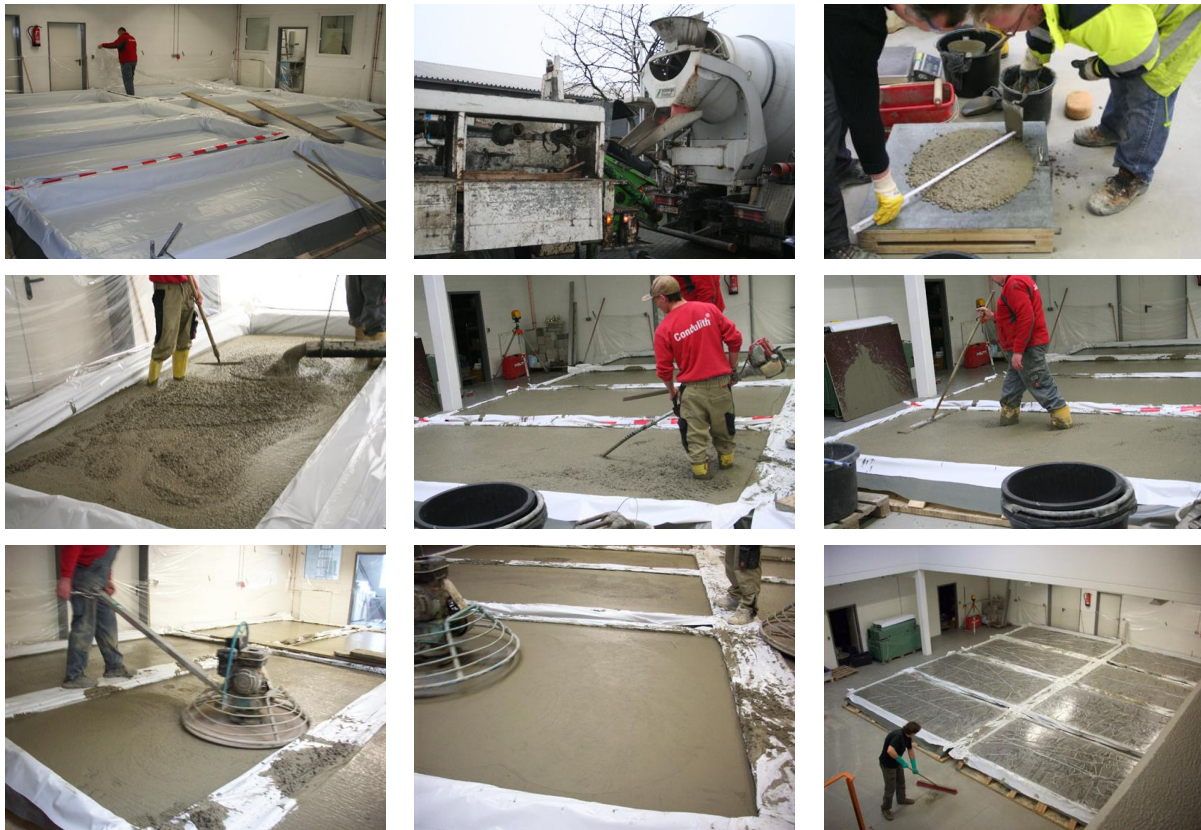
Bild 13 Betonage horizontaler Flächen am 29.02.2012
