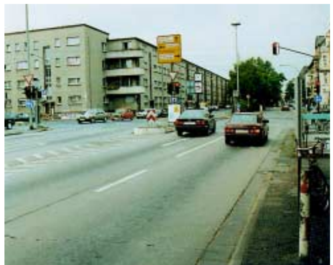
Bild 5: Kreuzungsbefestigung mit Beton in Frankfurt
