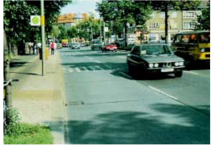
Bild 3: Bushaltestelle aus eingefärbtem Beton mit Fließmittel in Berlin
