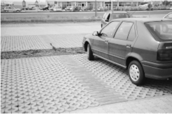
Bild 7: Gering beanspruchte Parkfläche mit brechsandgefüllten (Rasen-)Gittersteinen
