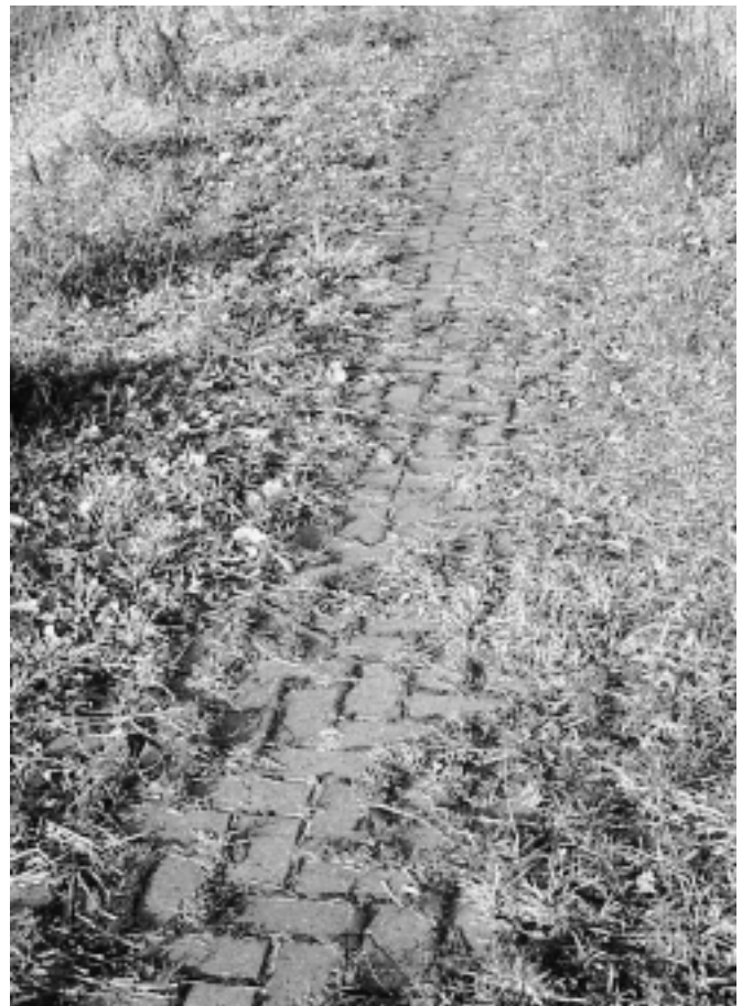
Bild 2: Überwachsen durch „Pflasterritzengesellschaften“ auf wenig beanspruchten Flächen
