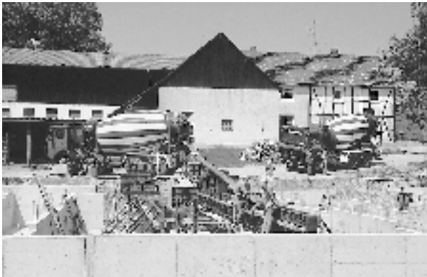
Bild 1: Betonieren des Güllekellers für einen Stall
