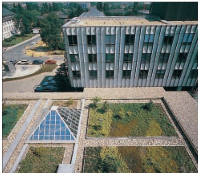
Bild 7: Blick auf Dach mit Randbereichen, Begrünung und Licht- öffnung
