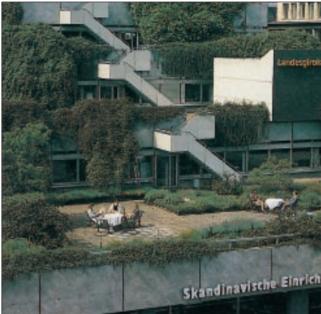
Bild 8: Dachgarten auf einem Bürohaus
