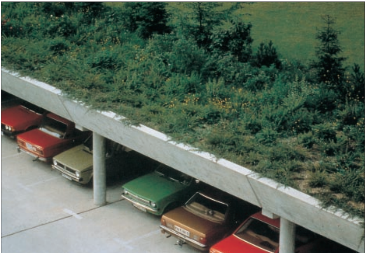
Bild 1: Begrüntes Dach über Pkw-Einstellplätzen [8]
