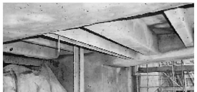
Bild 5 c: Zustand des ausgebesserten Bauteils
