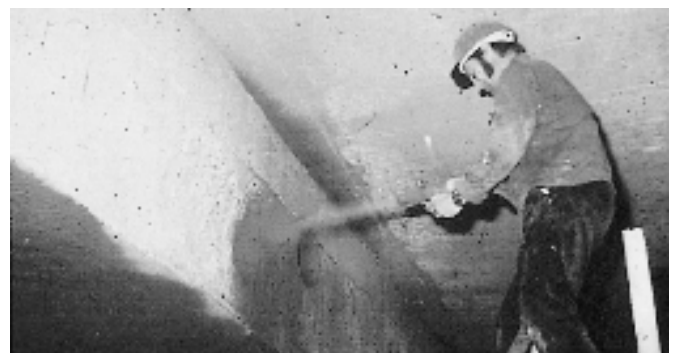
Bild 5 b: Aufbringen des Spritzbetons
