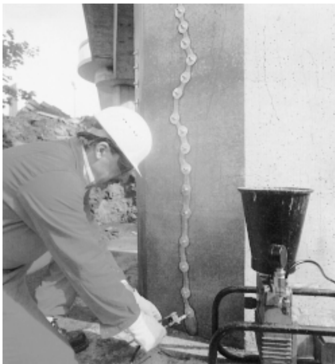
Bild 9: Rissverpressung an einer Stütze (Ph. Holzmann AG)
