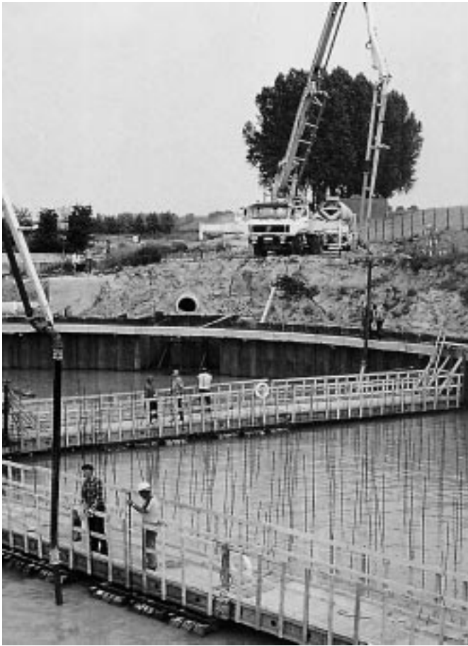
Bild 6: Pumpen des Unterwasserbetons einer Kläranlage
