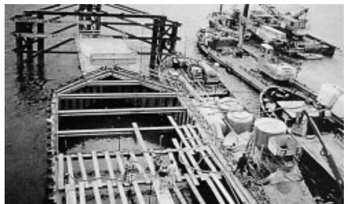
Bild 13: Herstellen von Tectocrete-Unterwasserbeton; rechts neben der Baugrube das Schiff mit Mischanlage für das Injektionsgut
