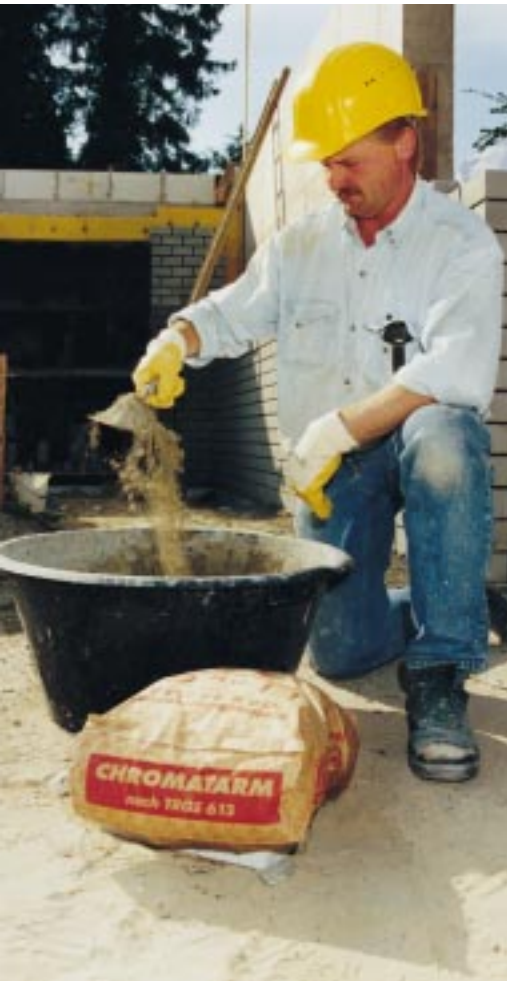
Abb. 1: Chromatarme Zemente und Produkte für eine händische Verarbeitung auf der Baustelle
