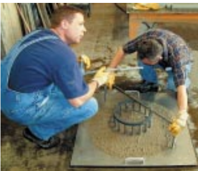
Bild 5: Versuche zur Verarbeitbarkeit an selbstverdichtendem Beton
