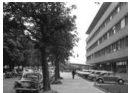
VDZ-Gebäude in der Tannenstraße (1956)
