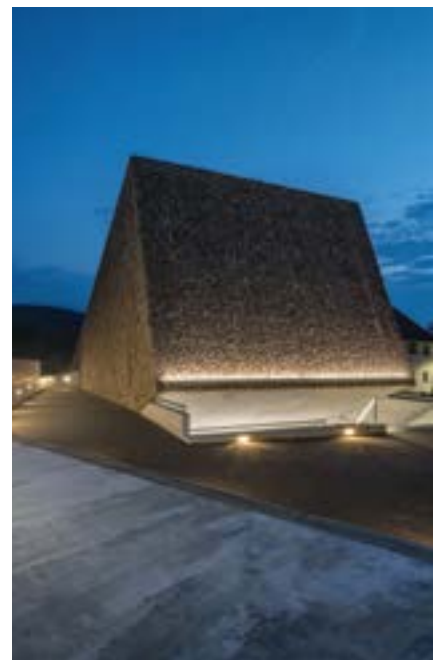
Beton. Für große Ideen. Konzerthaus Blaibach, Architekturpreis Beton 2017
